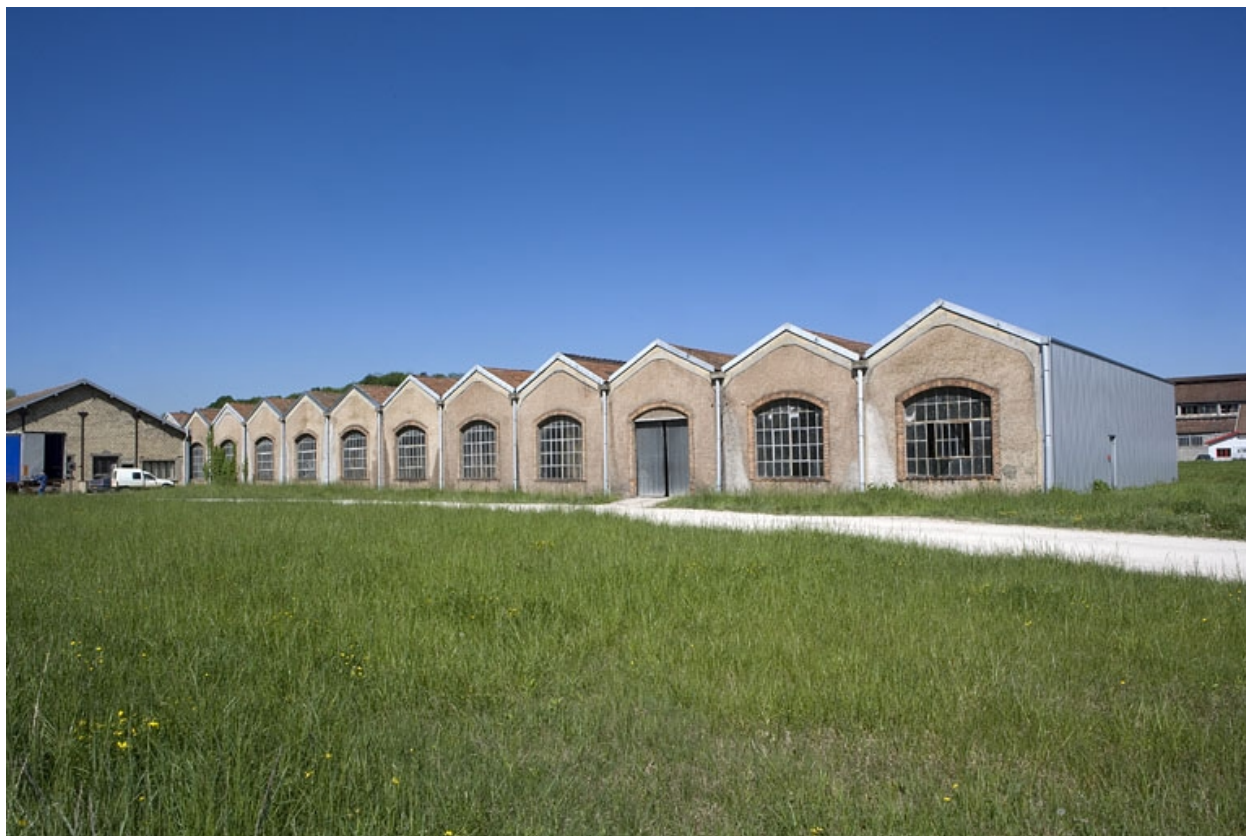
Magasin industriel. Façade sud.
