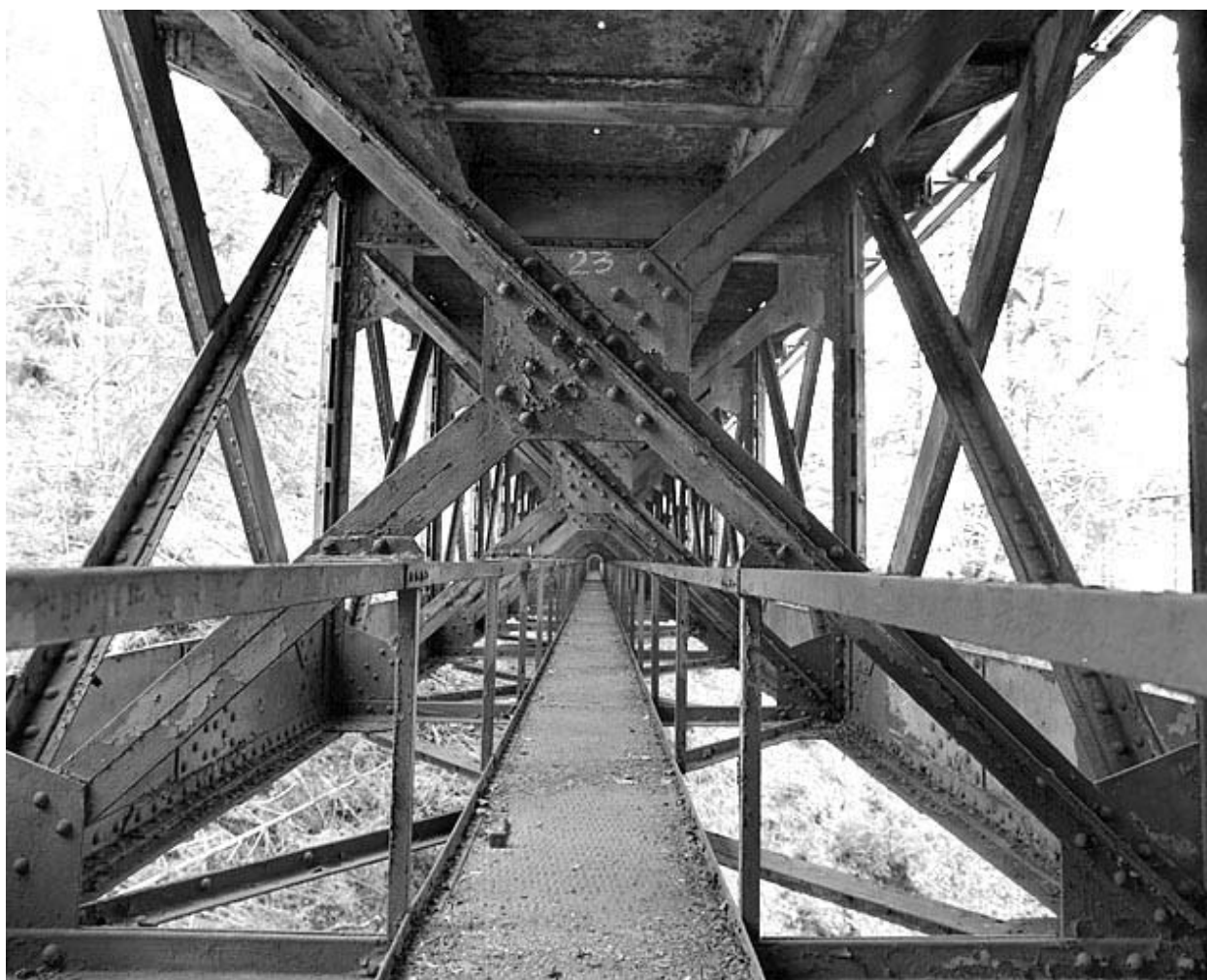
Viaduc : passerelle sous le tablier.
