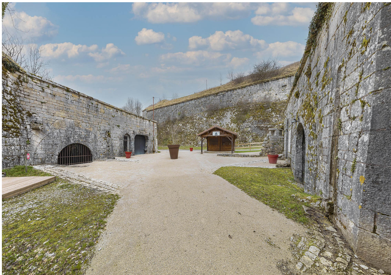
Vue de la cour intérieure.
