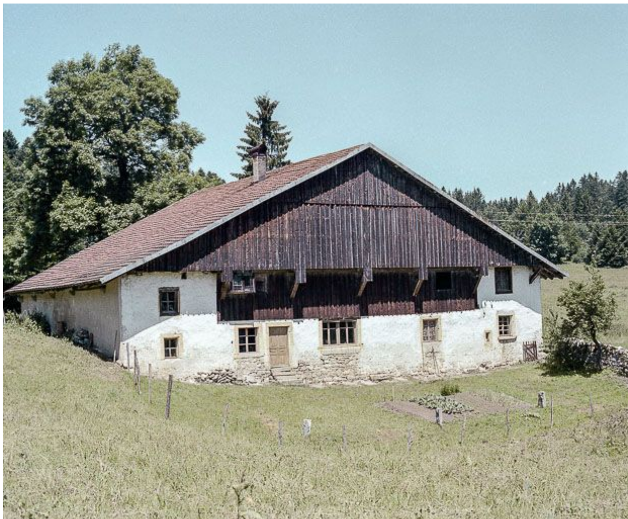
Façades antérieure et latérale droite.
