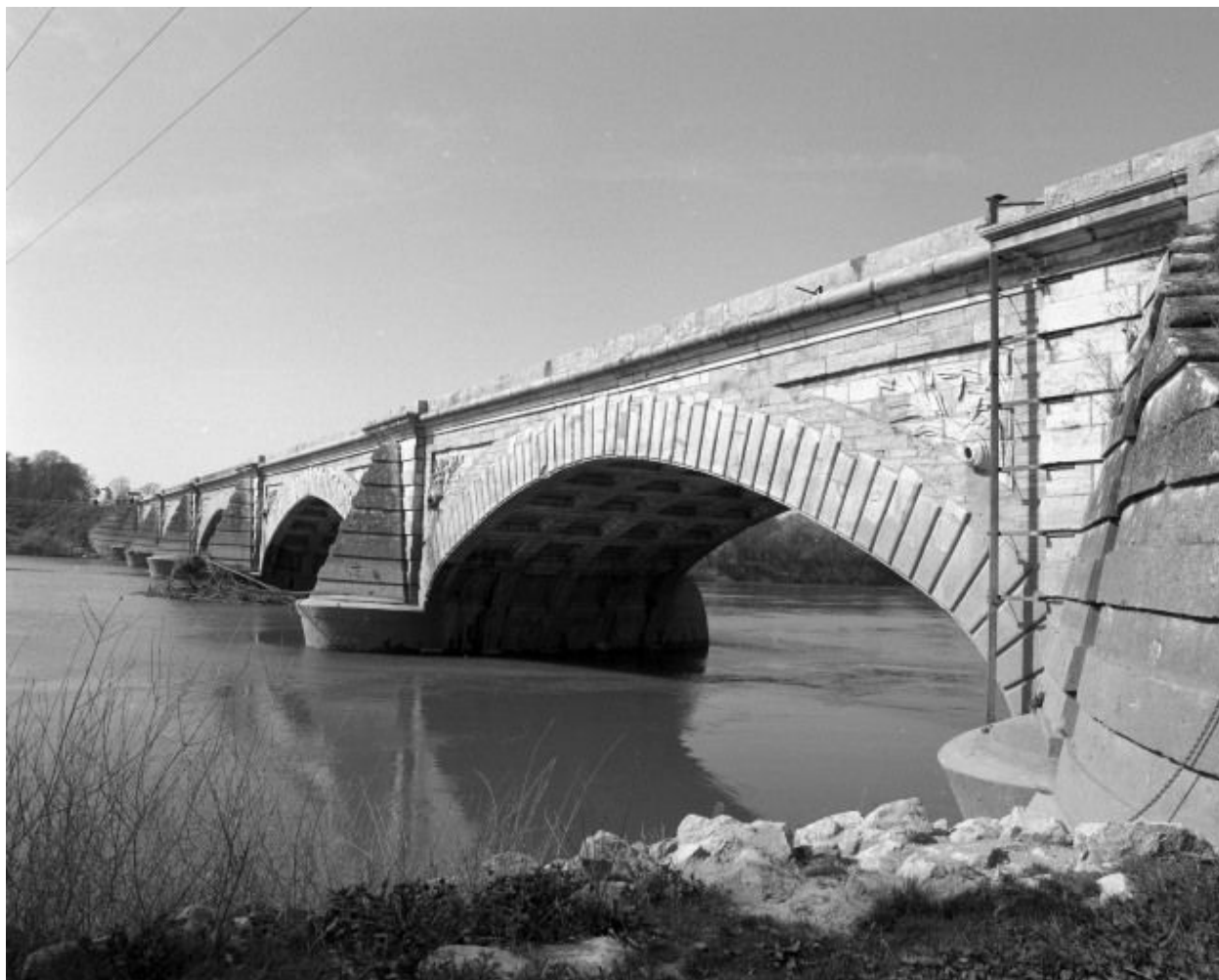
Vue d'ensemble rapprochée, en amont.
