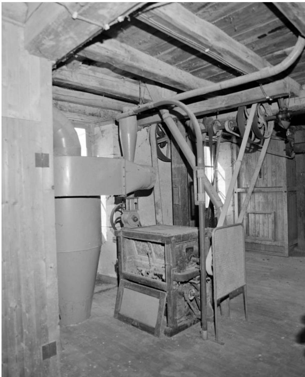
2e étage. Arbre à poulies et Trieur à son.
