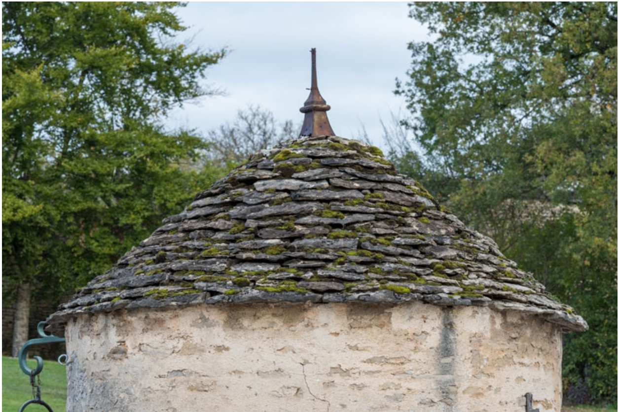
Détail de la toiture.
