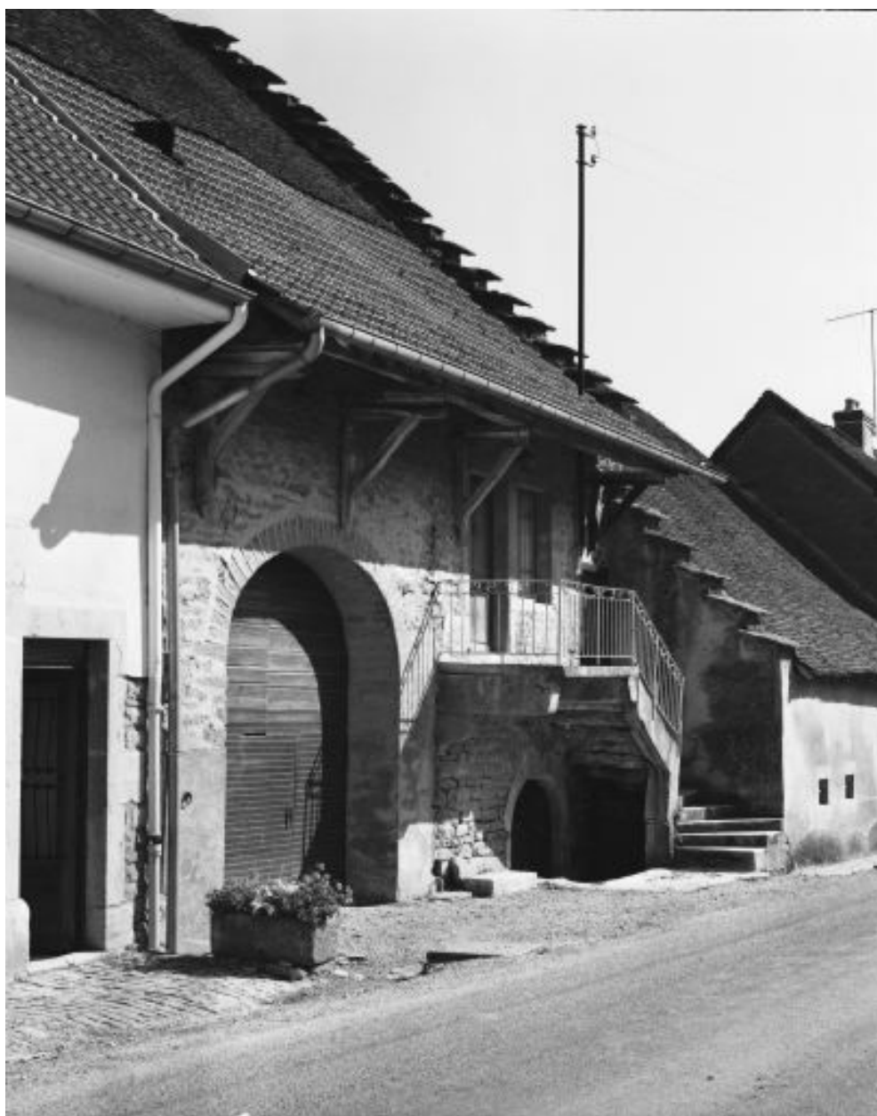
Maison située 36 Grande Rue.
