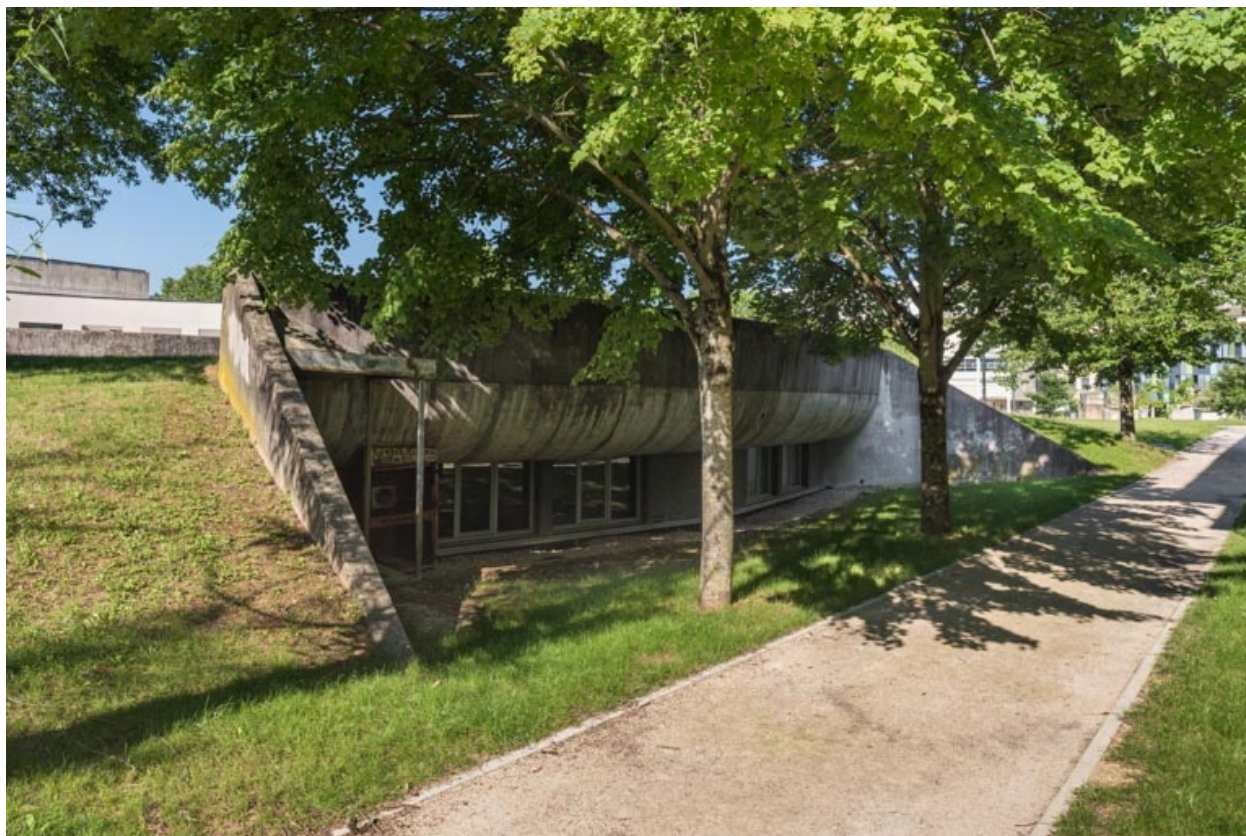
Aile semi-circulaire : fenêtre au nord.
