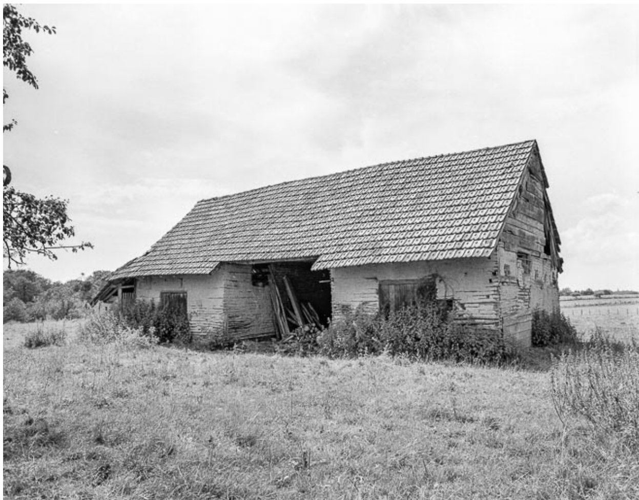
Ferme cadastrée 1963 AB 20 : façade antérieure.
