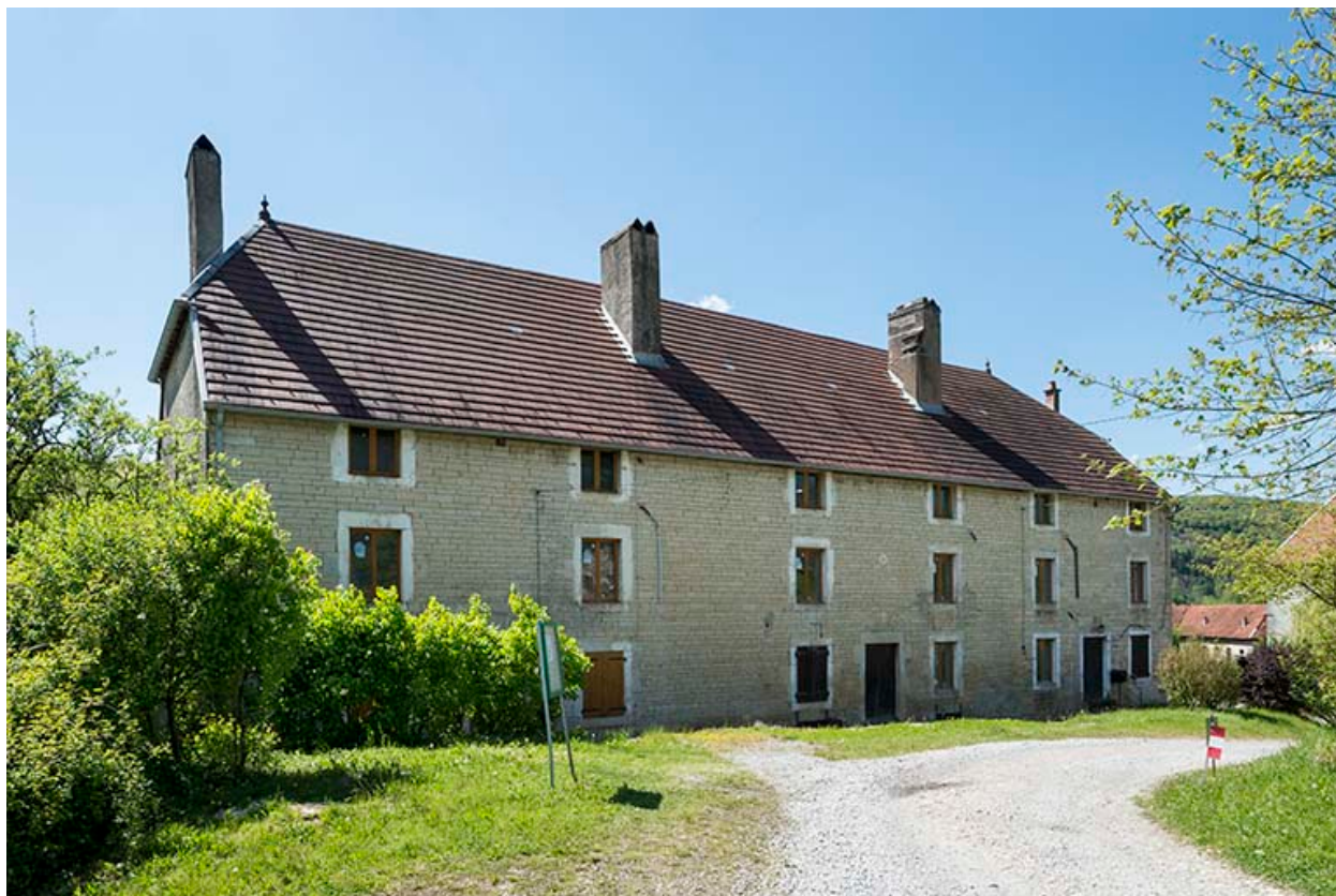
Logement ouvrier ouest. Façade sur cour.
