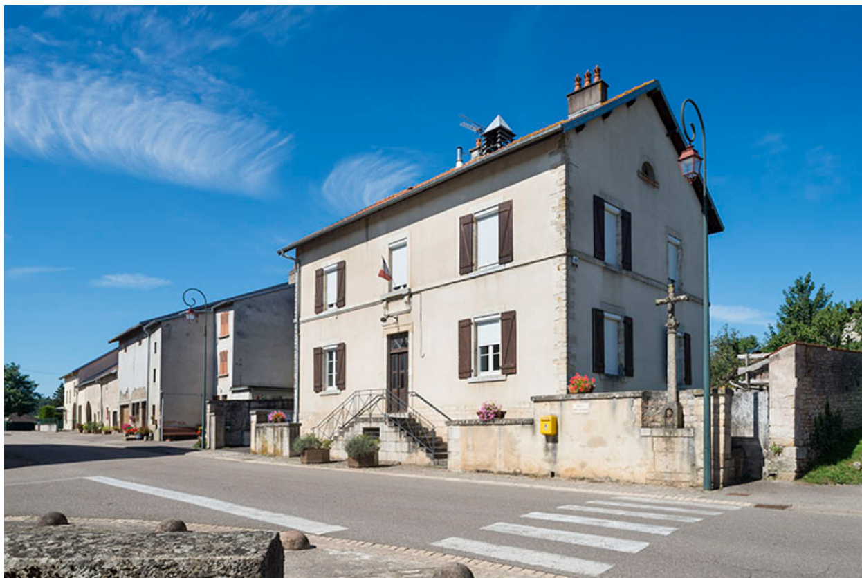
Vue d'ensemble de la maison commune.
