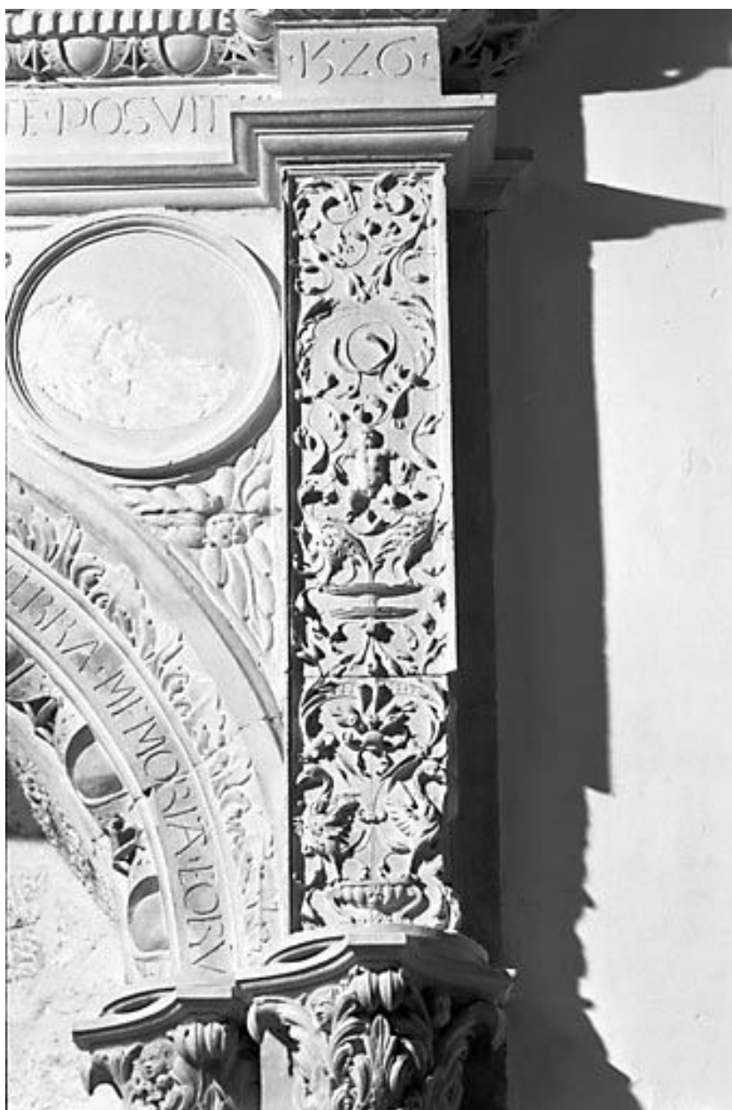
Détail : pilastre et écoinçon droits.
