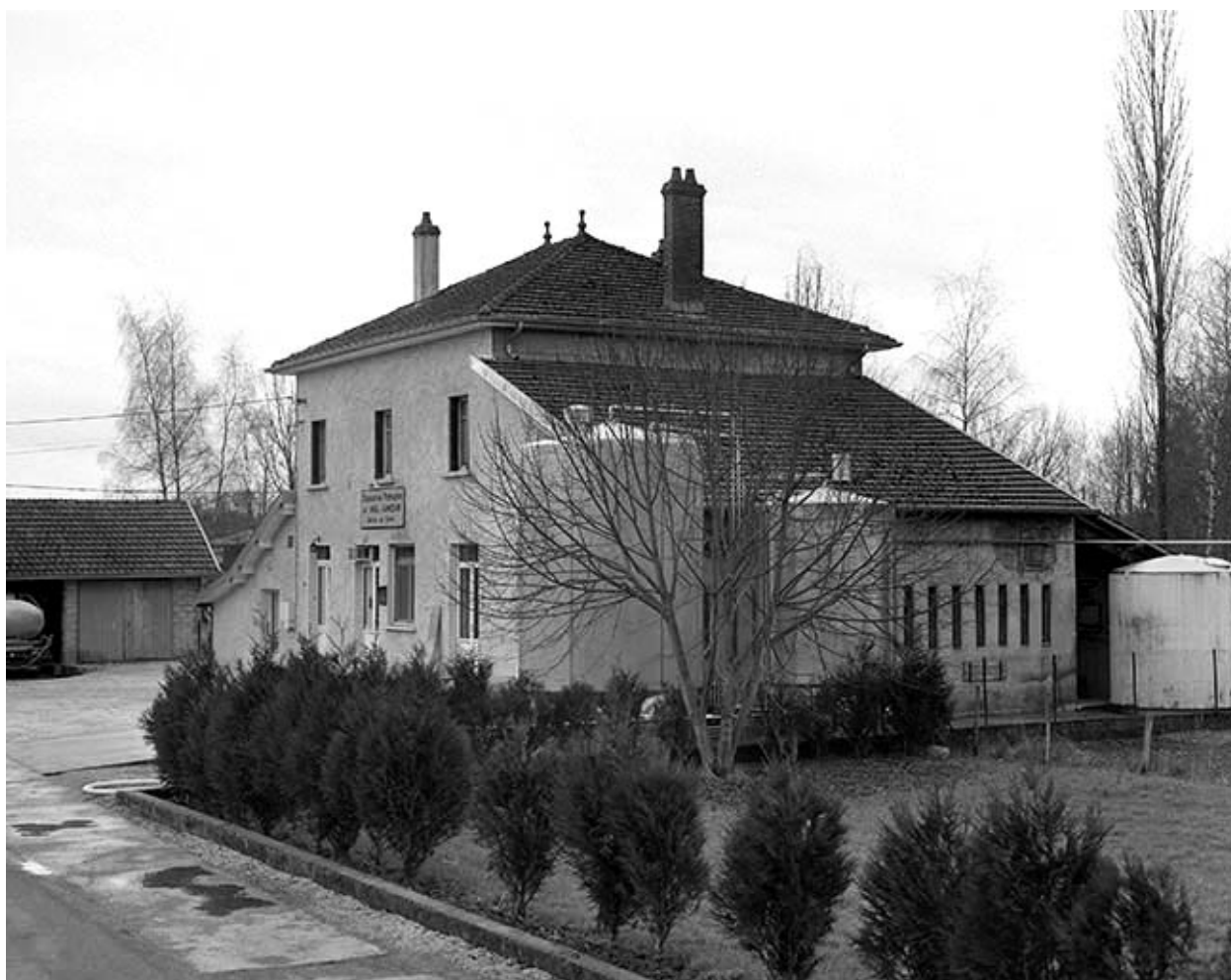
Vue rapprochée depuis la rue.
