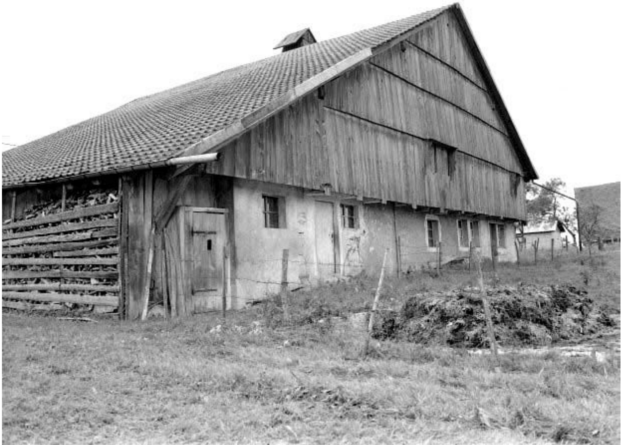
Façades postérieure et latérale droite.
