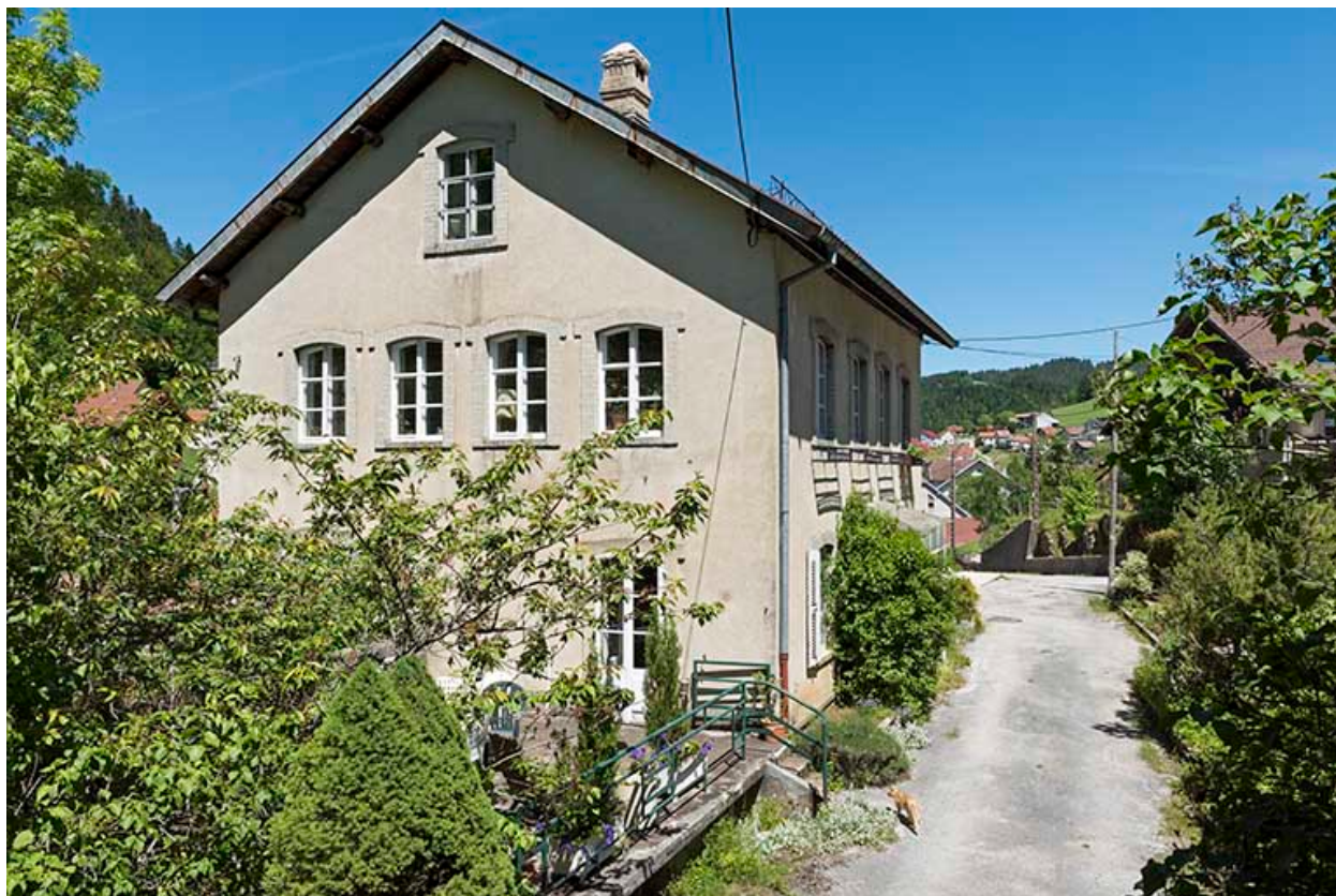
Maison : façade ouest.
