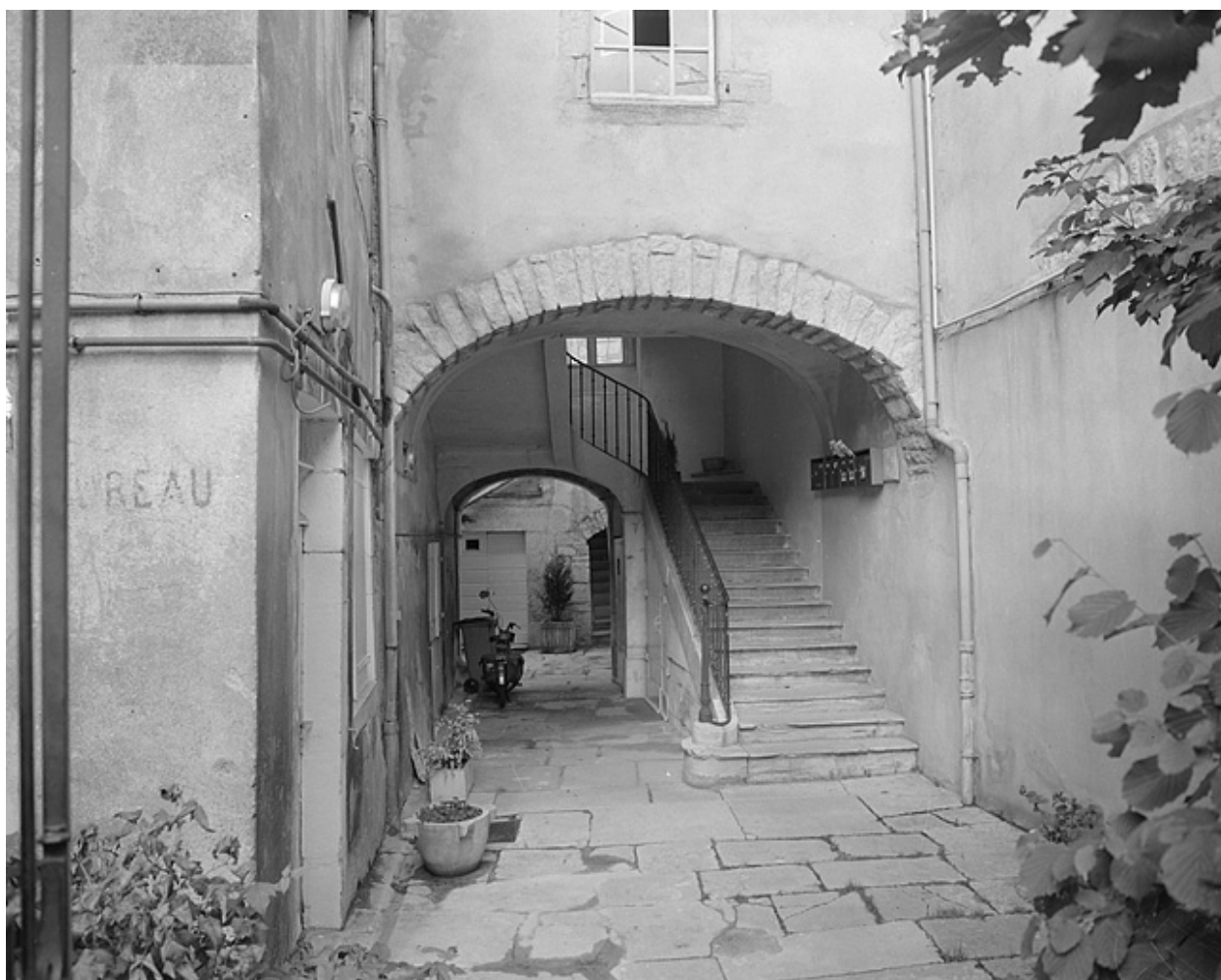
Escalier formant passage d'accès à la cour.
