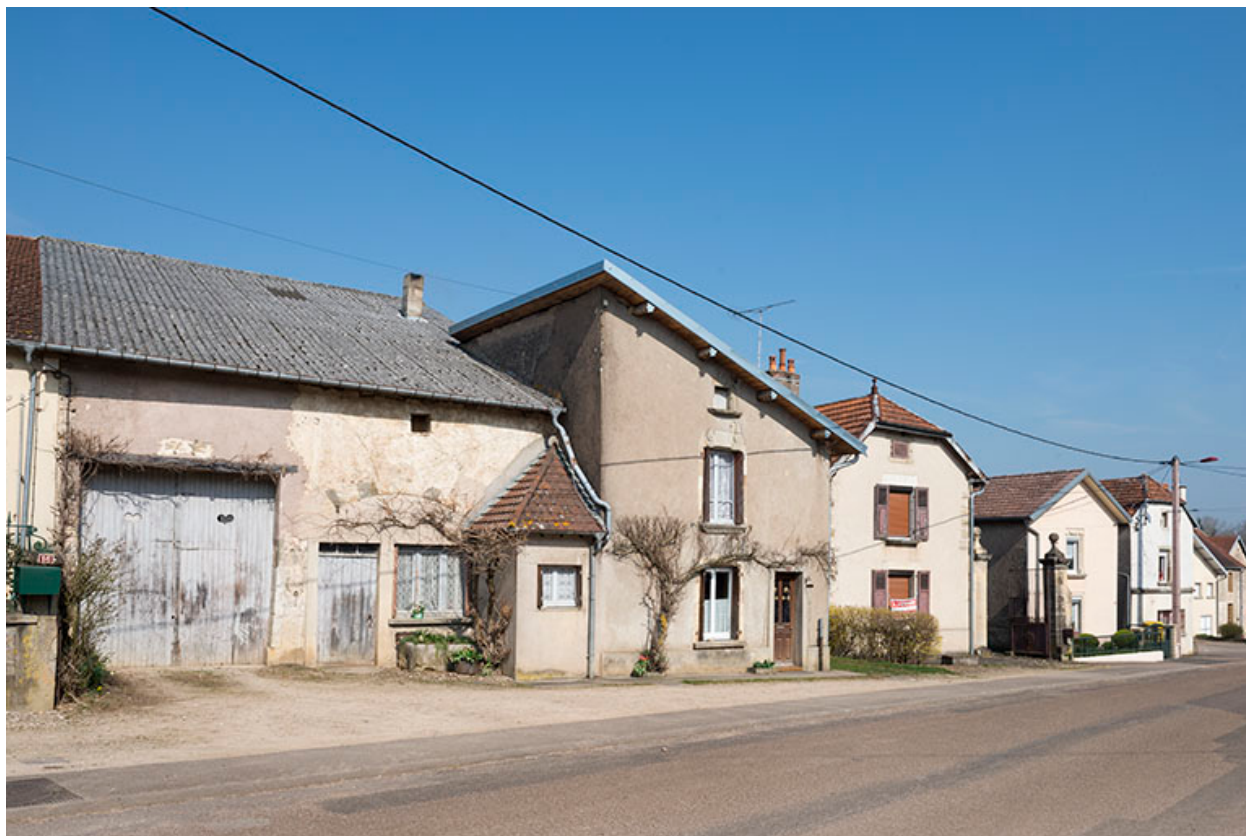
Vue générale, Grande rue.
