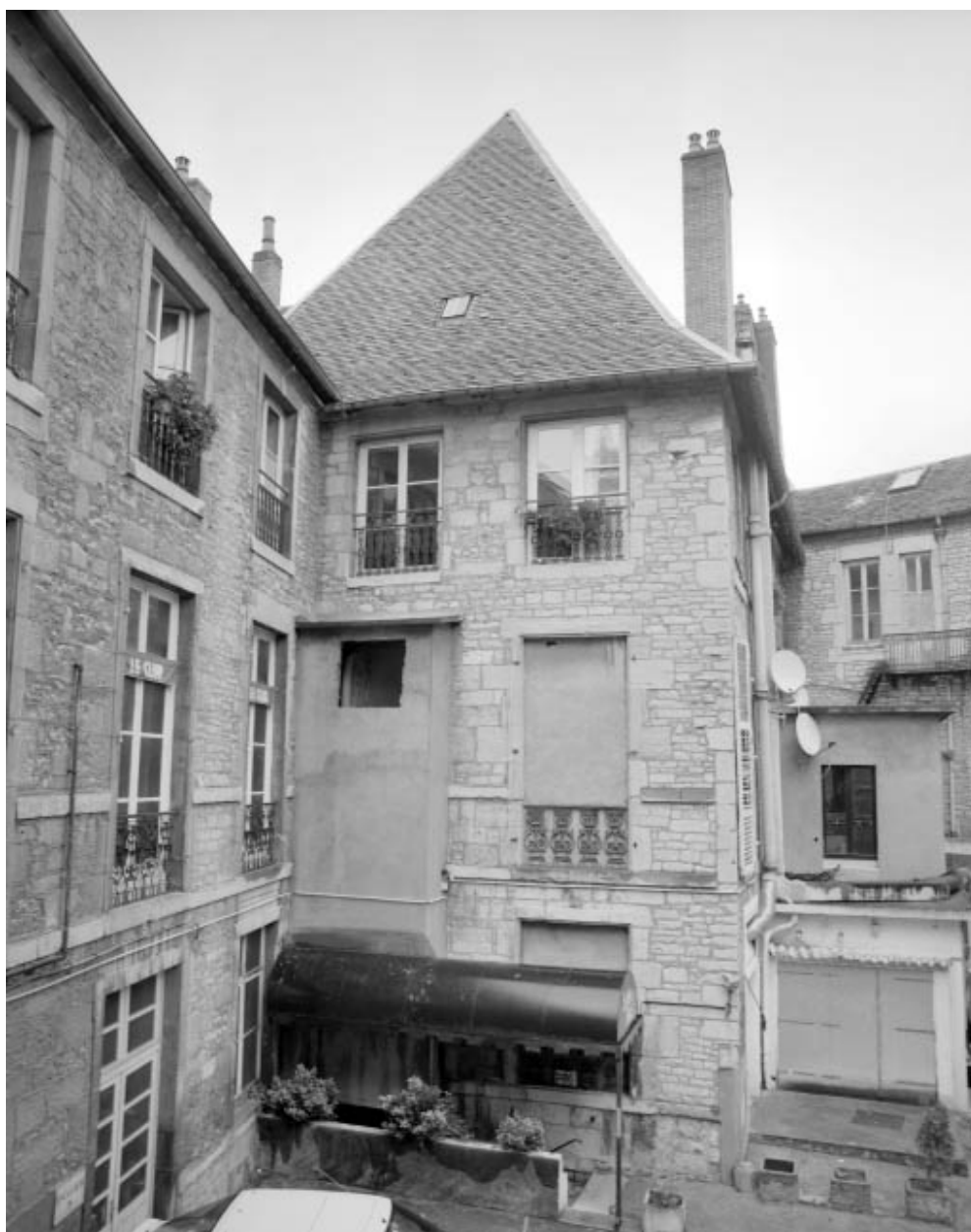
Logis sur cour : détail de l'avant-corps droit.
