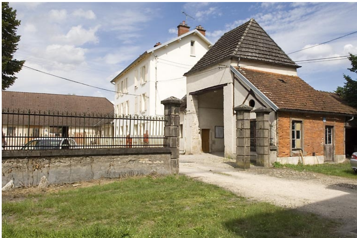
Bureau, logement et pavillon d'entrée.
