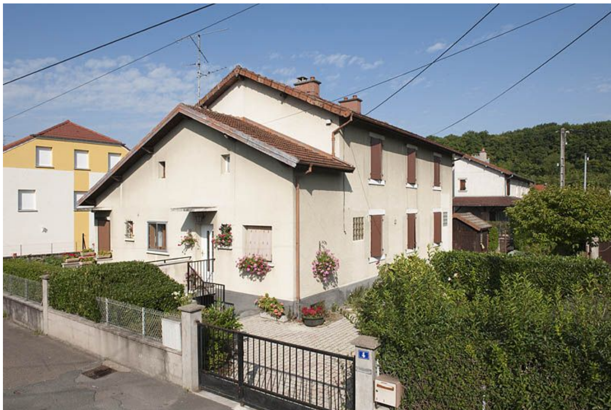
Habitation à 2-3 logements vue de trois quarts.
