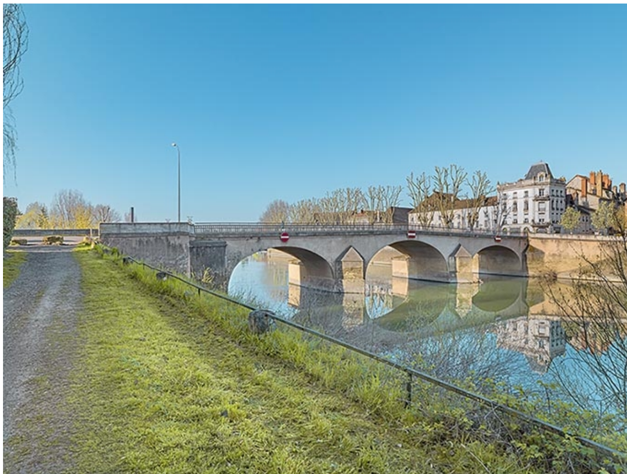
Vue d'ensemble du pont.
