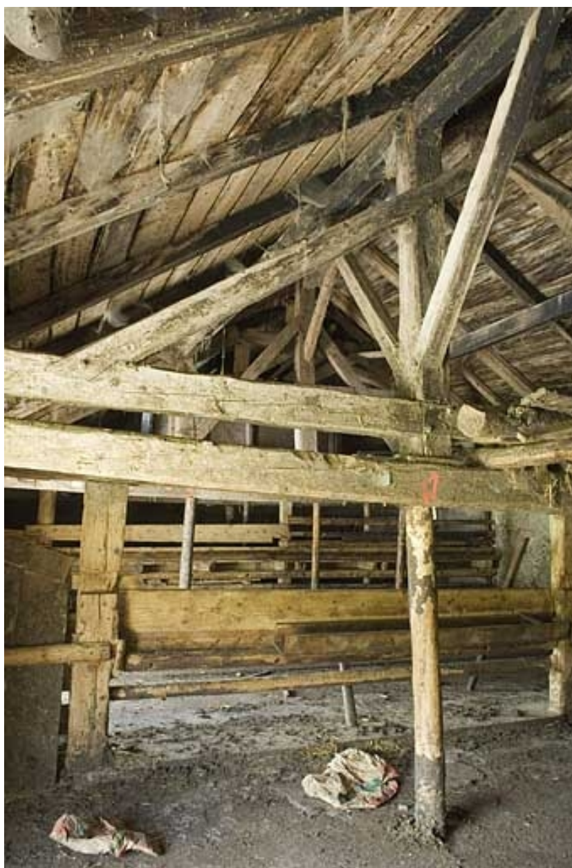
Détail de la charpente.
