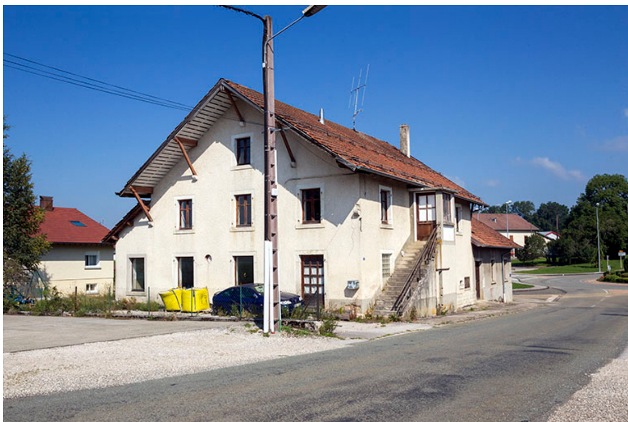
Façades antérieure et latérale droite.
