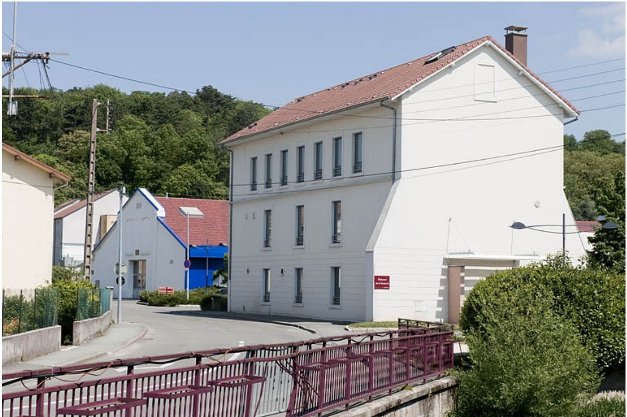
Bâtiment de bureaux. Vue depuis le pont.
