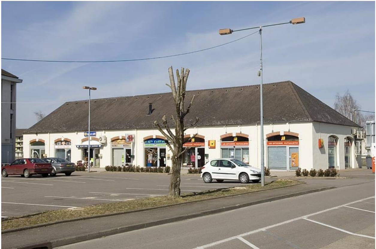
Atelier de fabrication (machines-outils). Façade sud.
