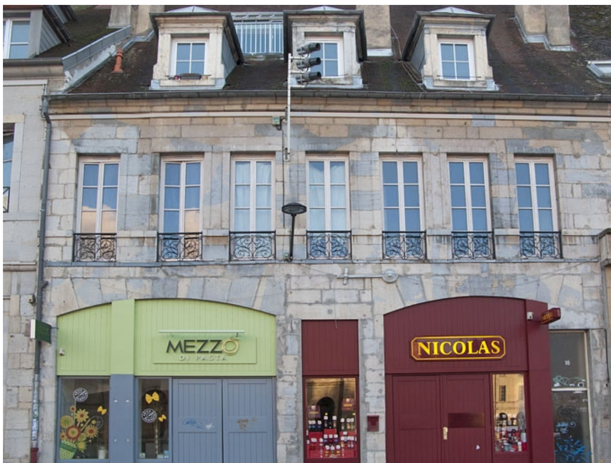
Vue d'ensemble rapprochée de la façade antérieure.
