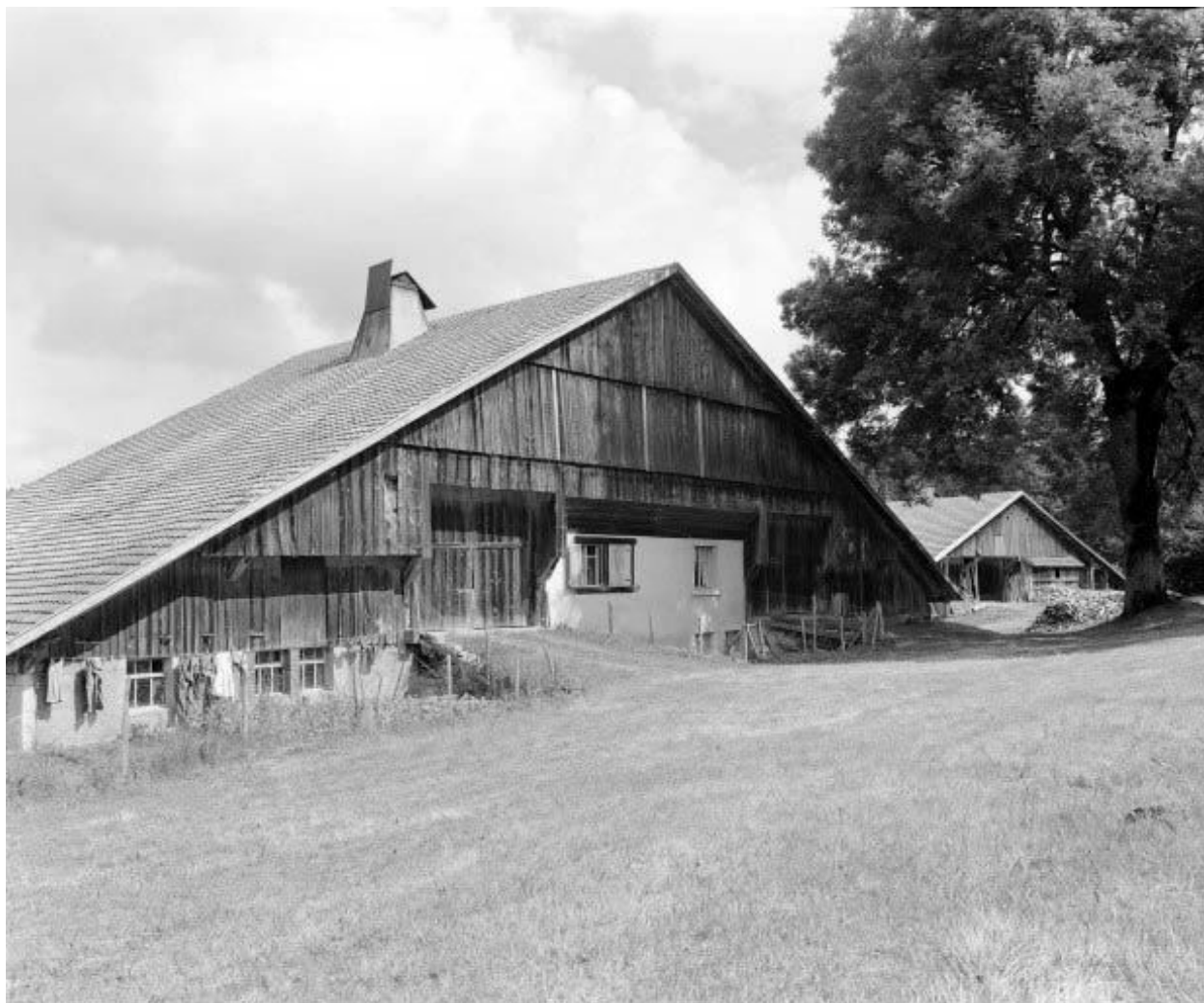
Fermes 1 et 2 : façades postérieures.
