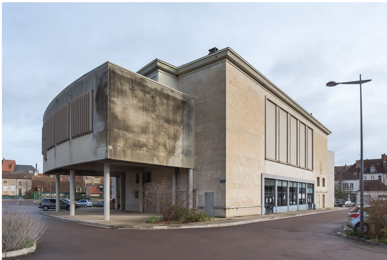
Façades postérieure et latérale droite.
