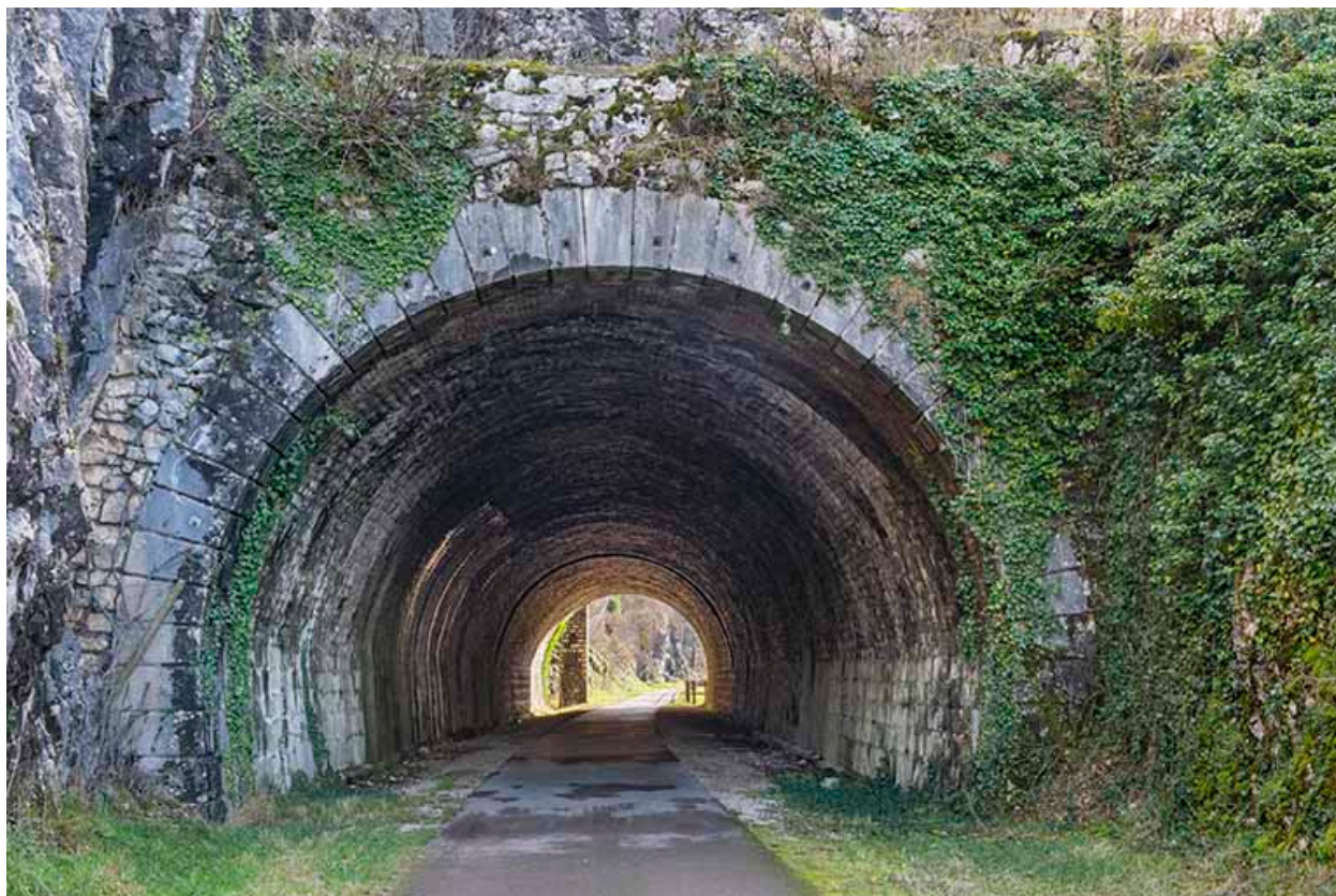
Entrée ouest du tunnel.
