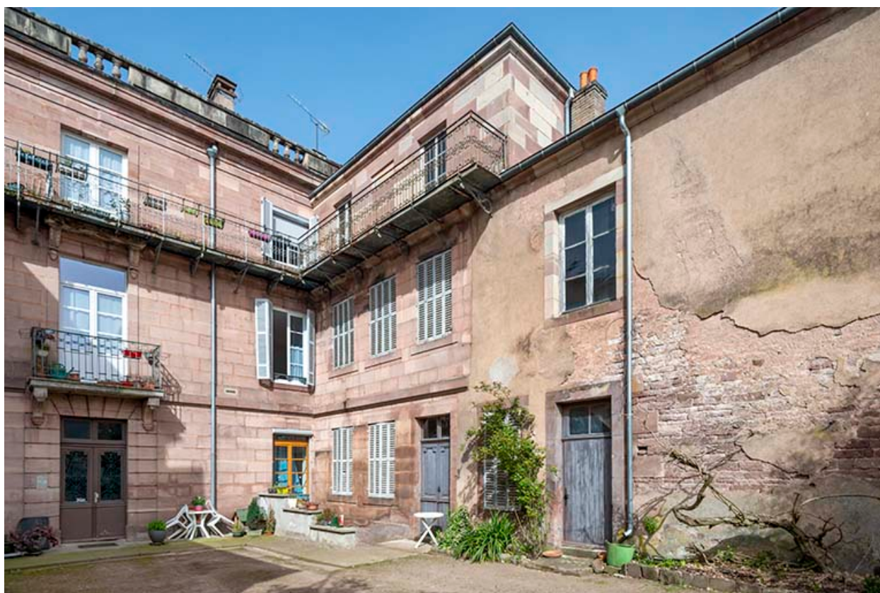
Façade sur la cour.
