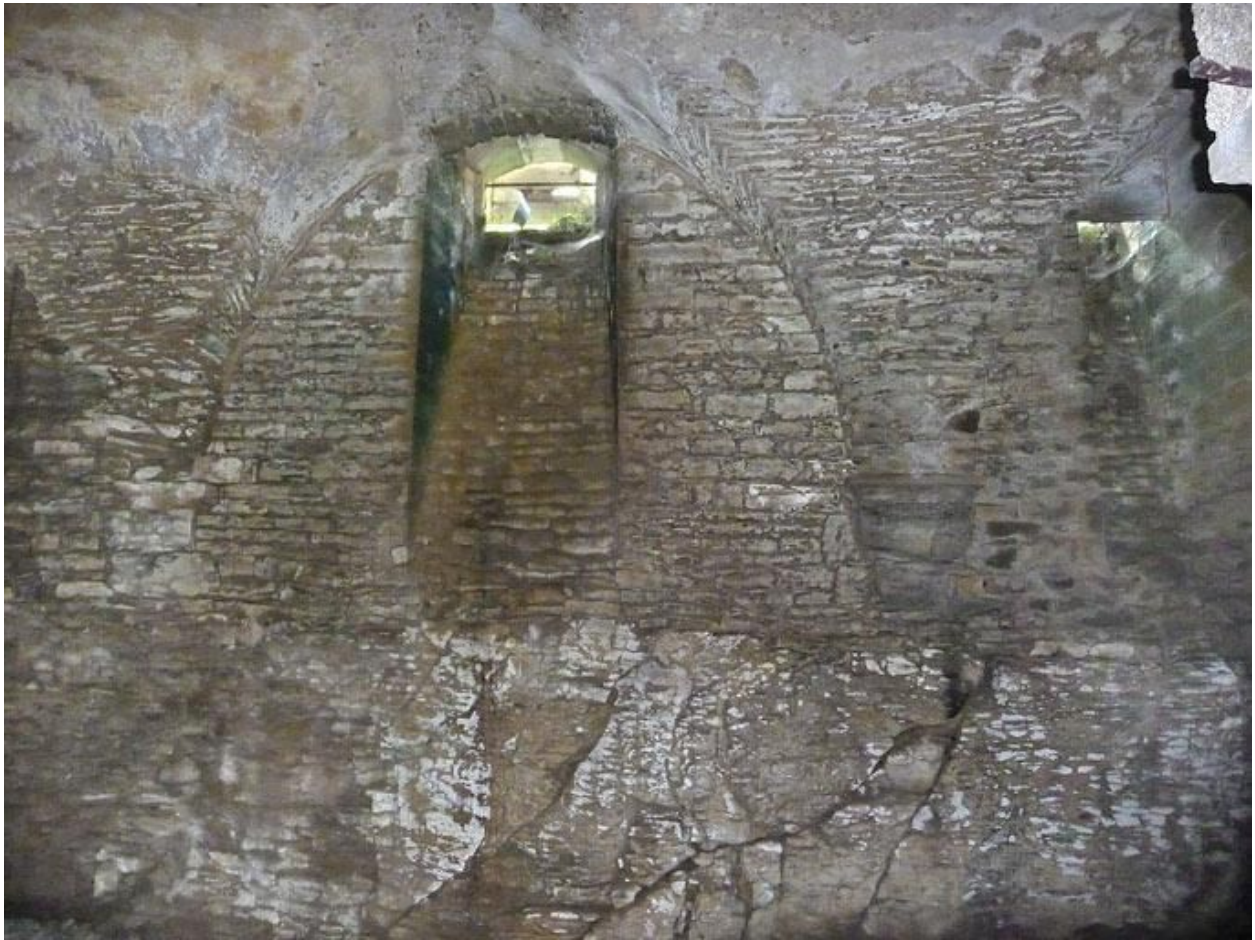
Cave sous la grange : soubassement rocheux, soupirail et culots.
