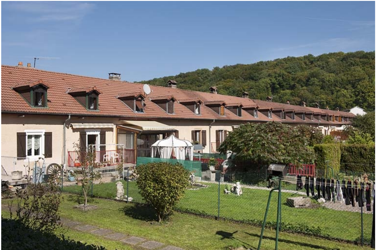
Caserne G. Façade postérieure depuis le sud-ouest.
