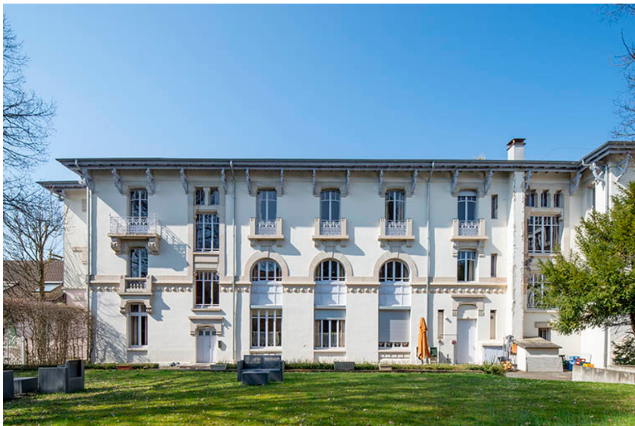
Façade est, vue de face.
