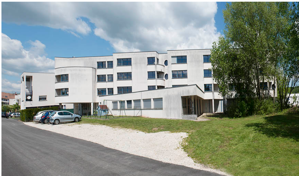
Façades ouest de l'internat.
