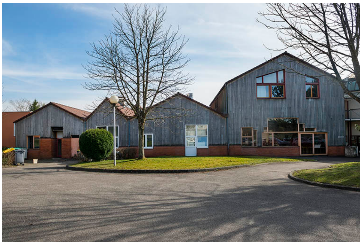
Pignons nord de la restauration.
