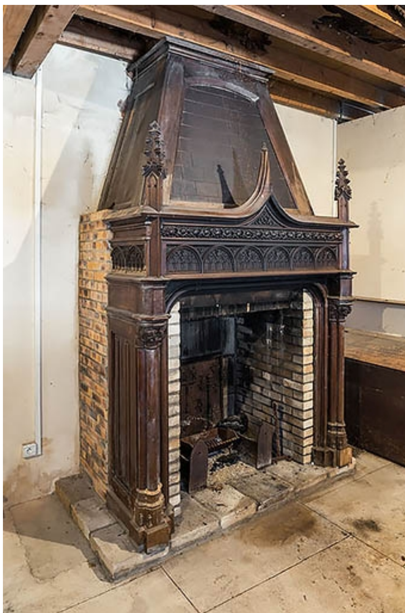
Corps central : cheminée au rez-de-chaussée.
