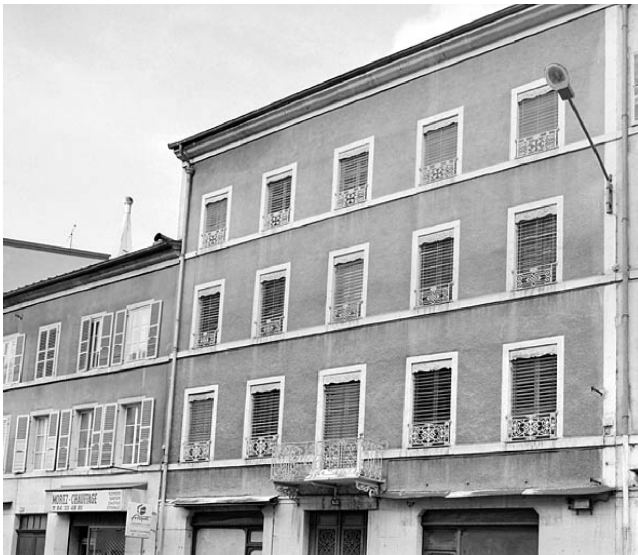
Elévation antérieure : les baies des étages.
