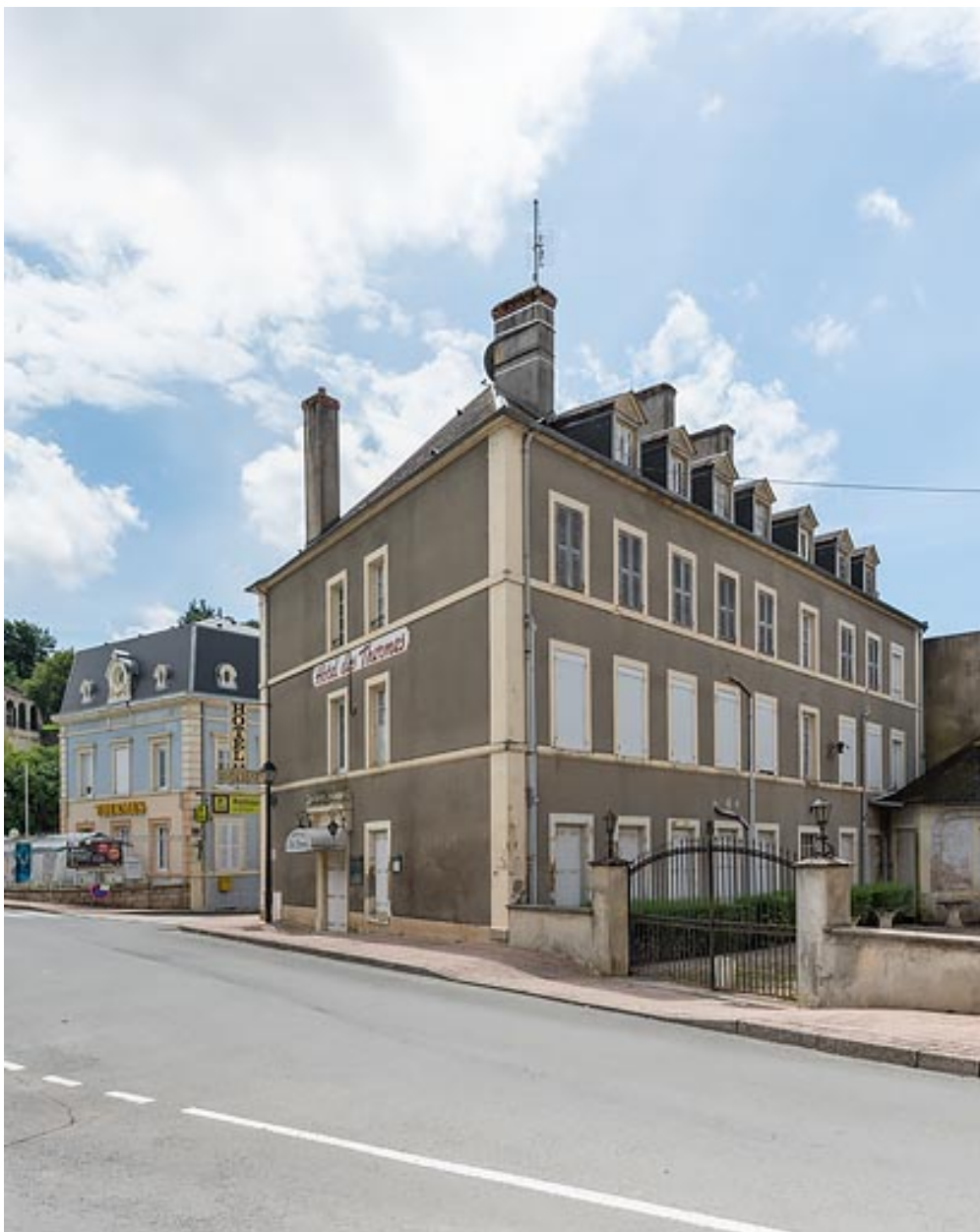
Façade est et façade nord.
