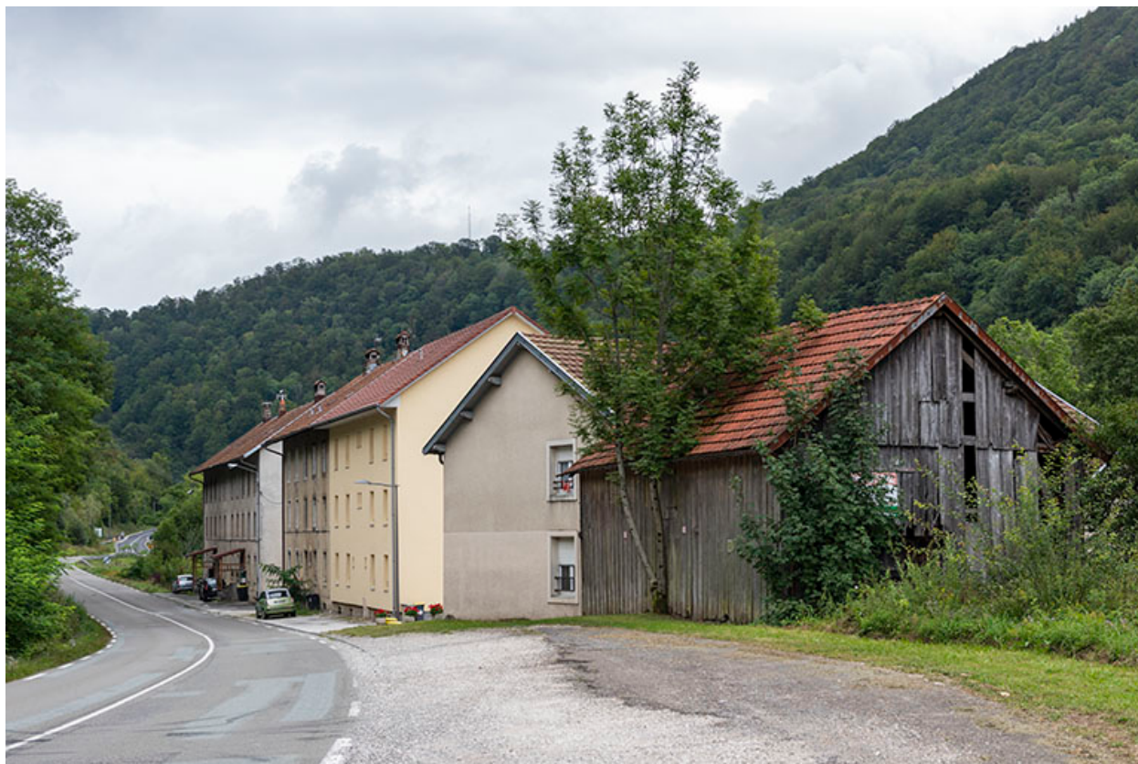
Vue d'ensemble, depuis la route à l'ouest.
