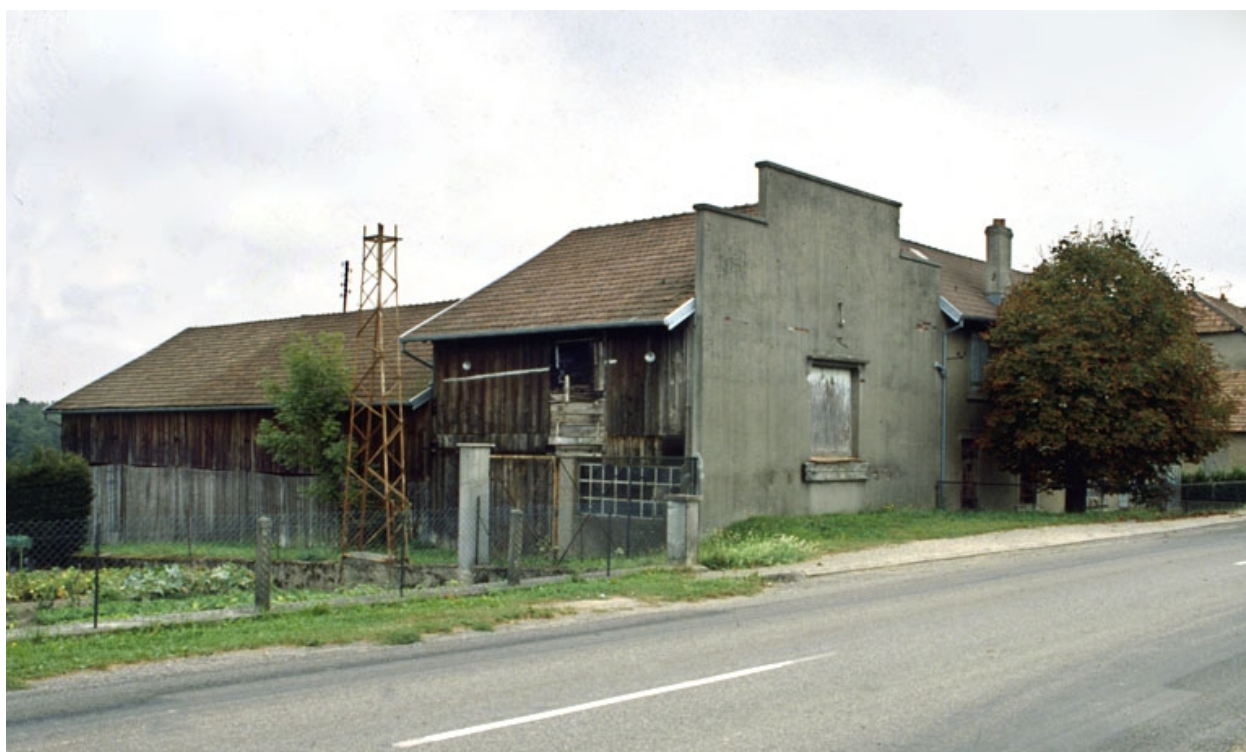
Magasin et entrepôt industriel.
