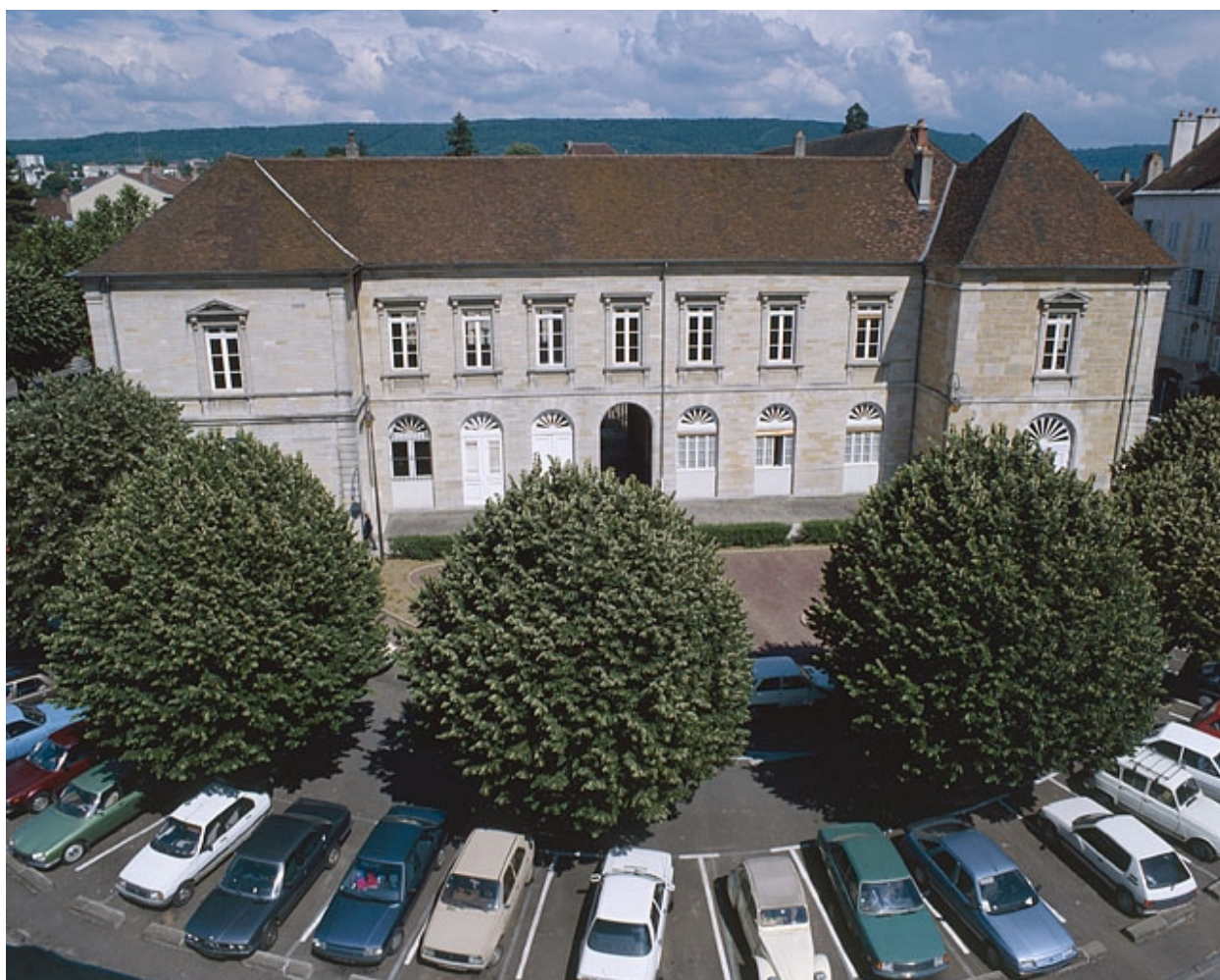
Façade ouest, vue d'ensemble.
