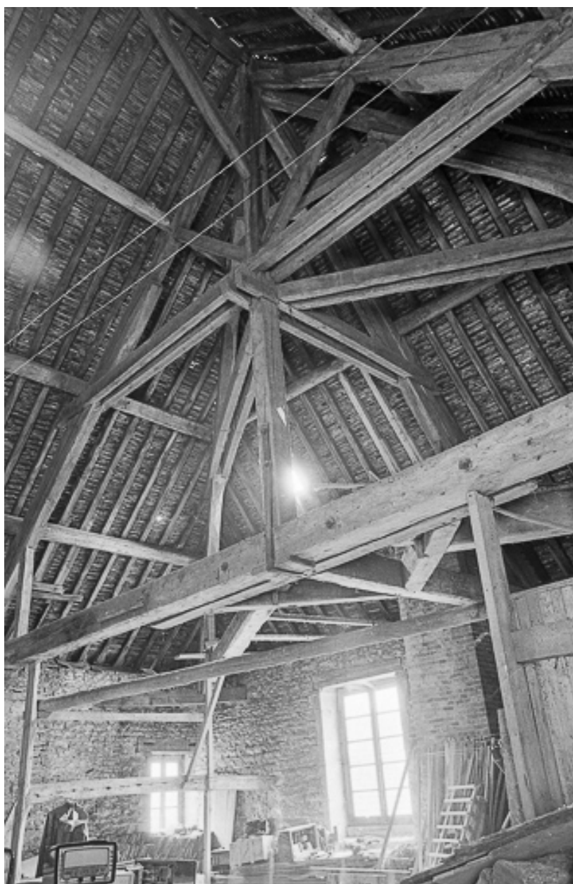
La charpente du haut fourneau en 1979.
