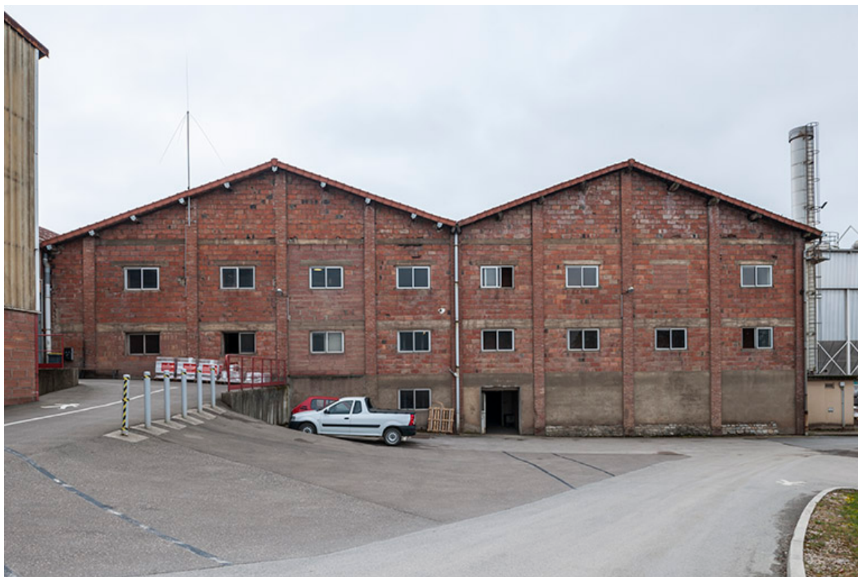
Murs-pignons de l'atelier de fabrication (actuellement UL 3).
