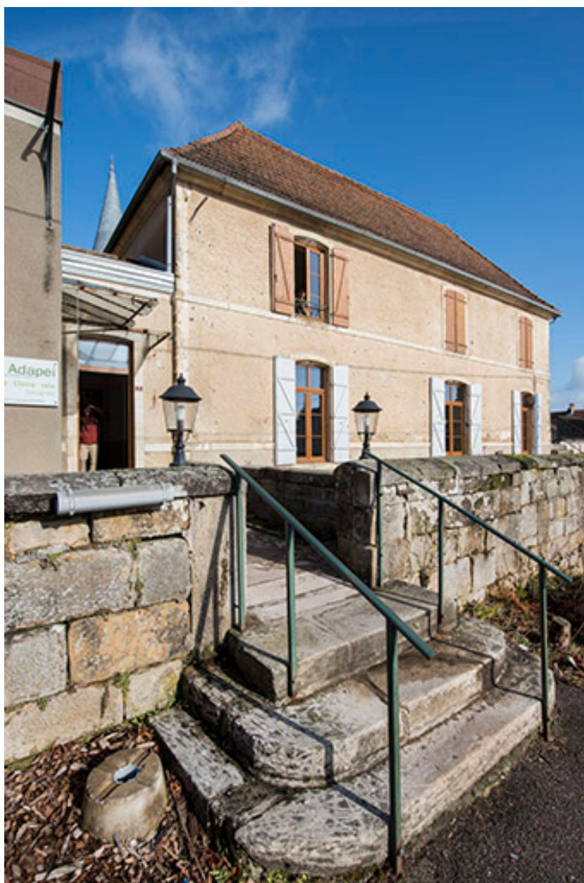
Perron depuis la rue Montgillard.
