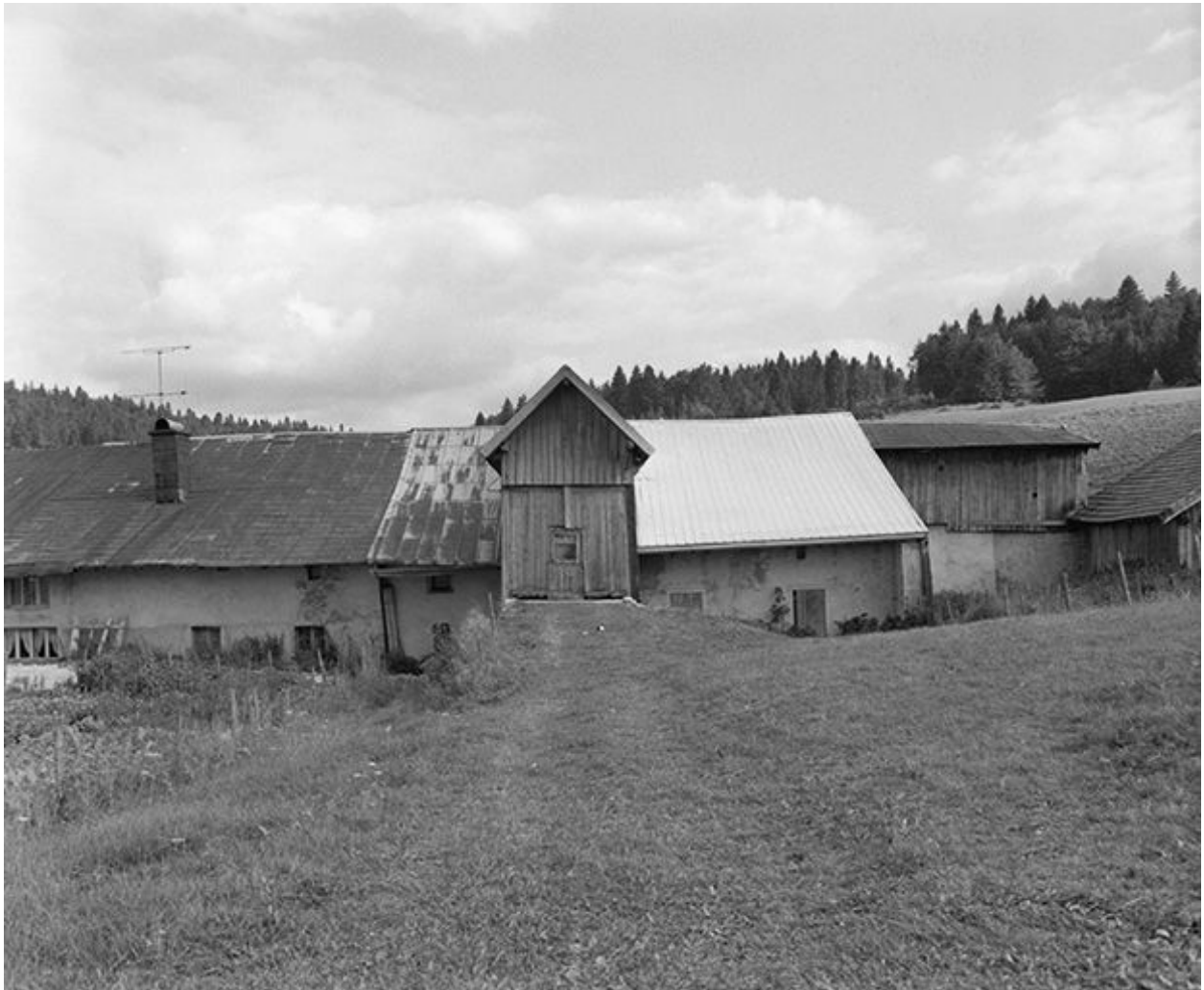
Façade postérieure avec pont de grange.
