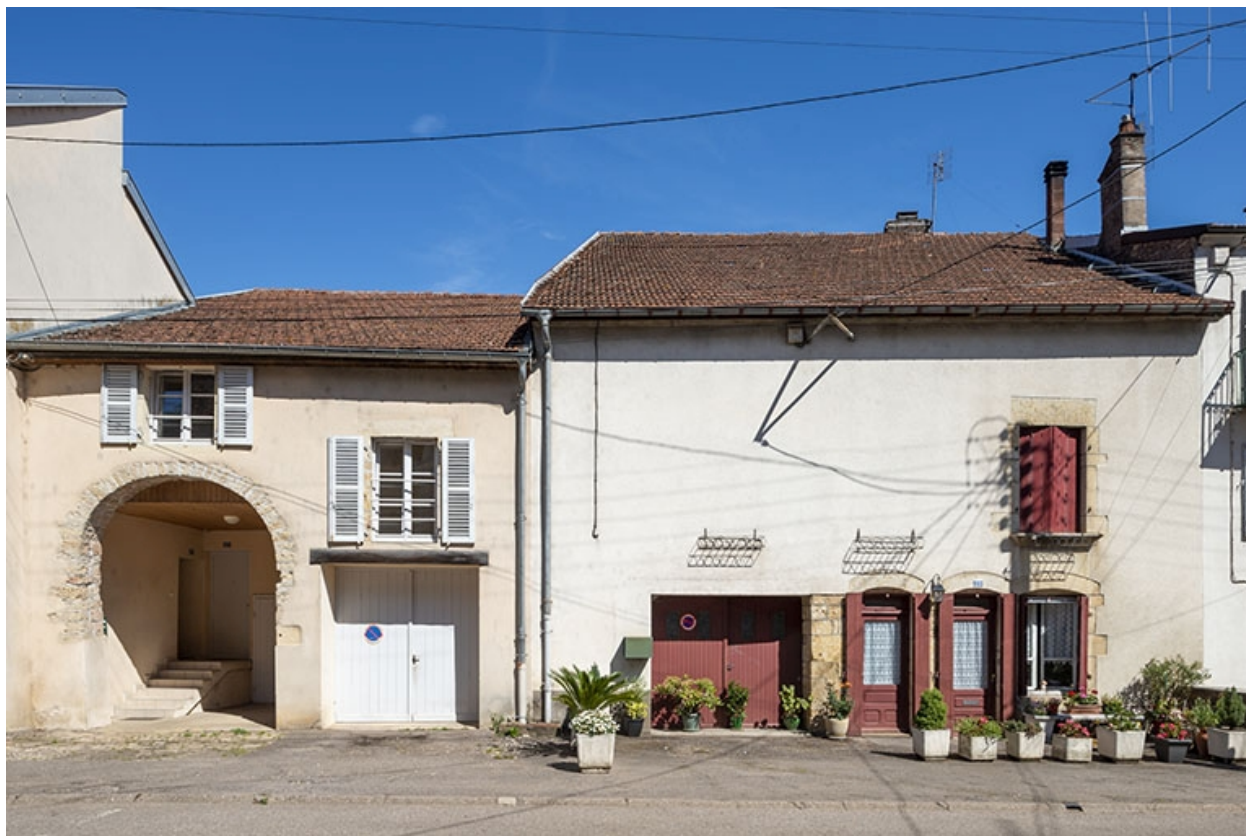
Les n° 27 et 29 de la rue Thiers.
