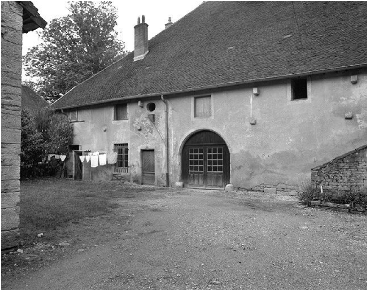
Façade antérieure, partie gauche.
