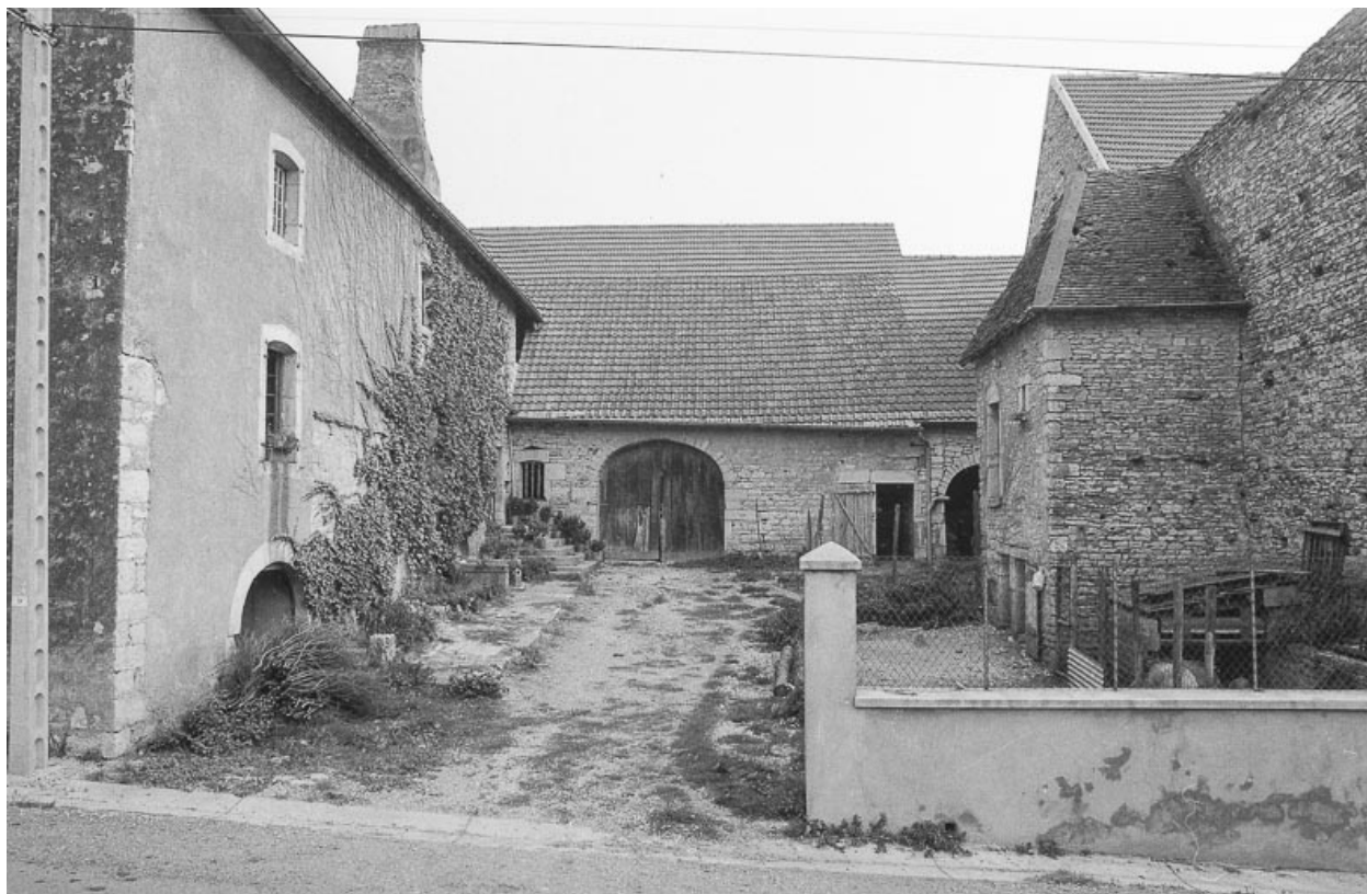
Façades sur cour.
