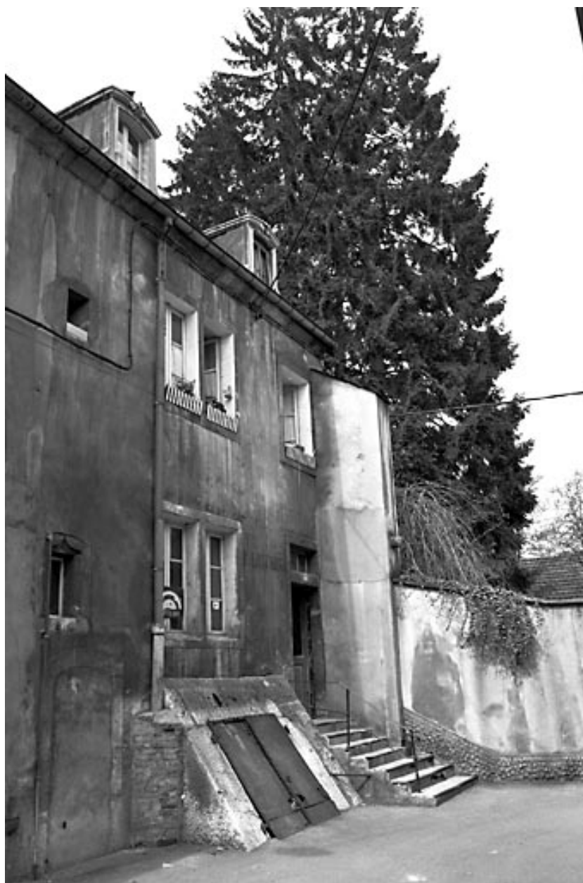
Maison située 10-12 rue Parguez.
